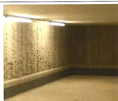
Schematisches Foto mit Darstellung der sichtbaren Bohrpfehlwand und der vorgesetzten Aufkantung für den Anschluss der Beschichtung
